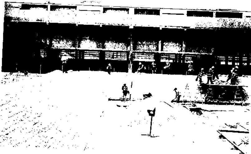
Xây dựng dự án bồn chứa condensate - Dự án Điện Đạm Phú Mỹ
